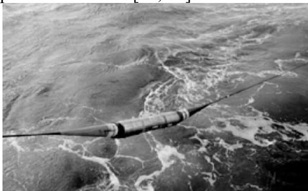
Рисунок 15 – Установка подводного оптического усилителя в открытом море [31]
