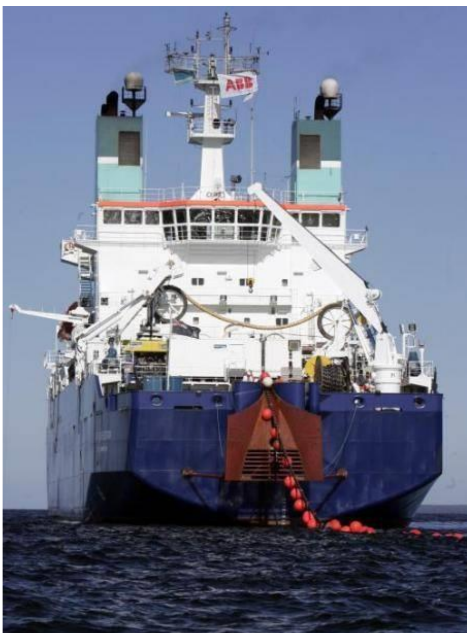
Рисунок 46 – Прокладка кабеля с корабля
